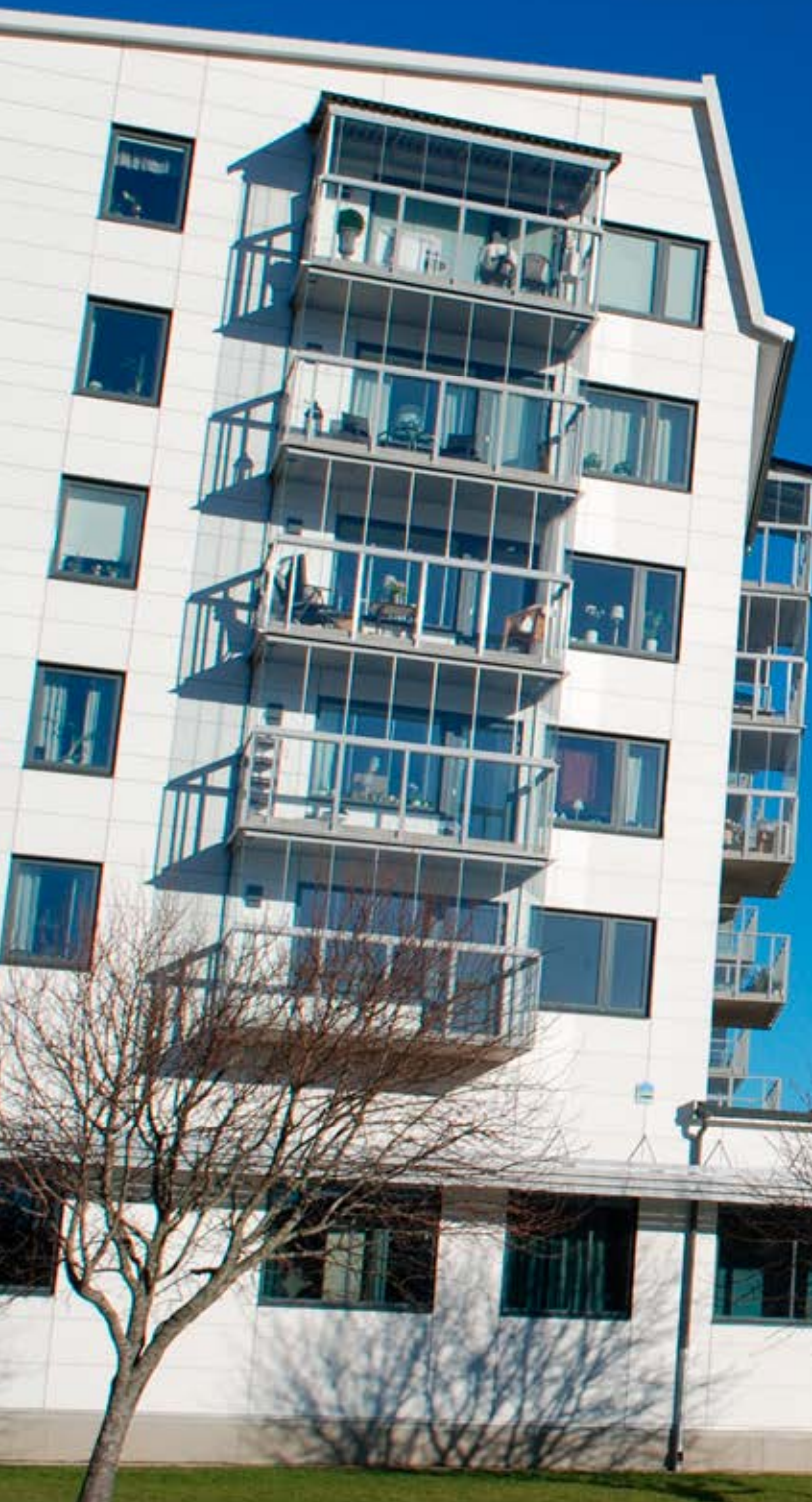
Borrhål kyler och värmer luften till kvarteret Eol i Uddevalla.
